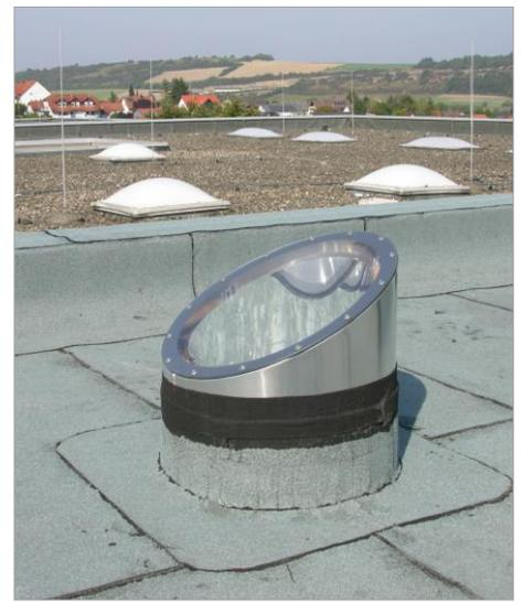
1. Dachverwahrung für Flachdach von 0° bis 2°, aus Aluminium 1 mm dick, mit Acrylglas-Ellipse, passend für optische Röhren mit 45 cm Durchmesser.
